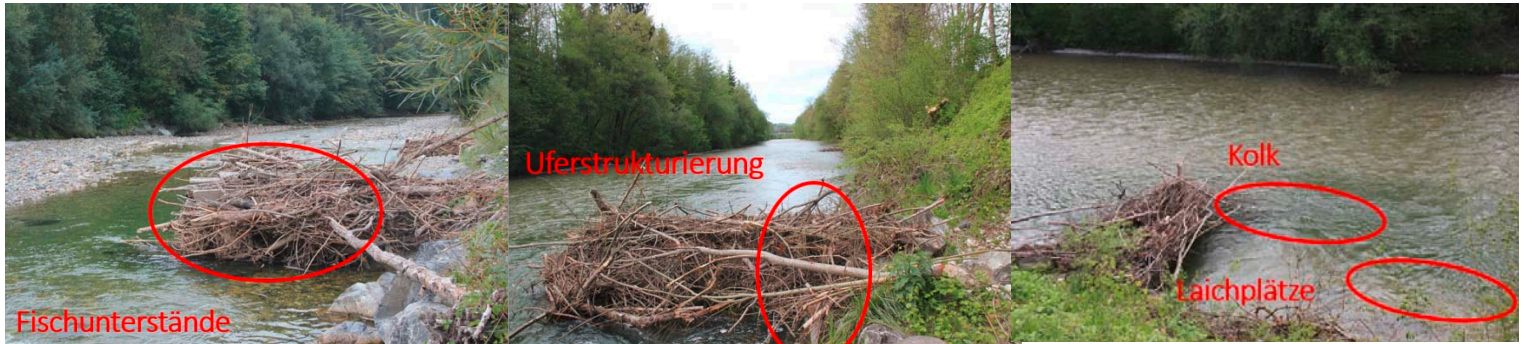
Beispiel Totholzrechen in der Emme (div. Standorte) mit Eisenbahnschienen oder Holzpfählen, Kosten 2 000-3 000 CHF (aus Vortrag Oliver Hartmann, Fischereinspektorat) Exemple de peignes de bois morts dans l'Emme (divers sites) faits de traverses de chemins de cher ou de pieux en bois, coût CHF 2 000 à 3 000 (tiré de l'exposé d'Olivier Hartmann, de l'Inspection de la pêche)
